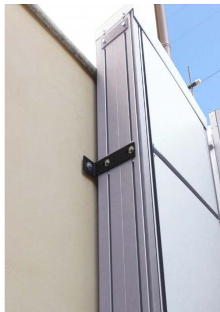
Dettaglio del fissaggio di Opal
